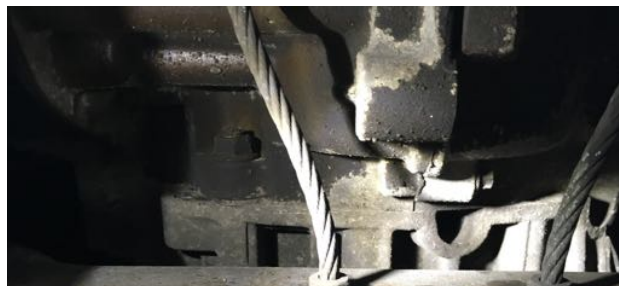
Jonction moteur / boite (absence de suintement au niveau du joint spi)
